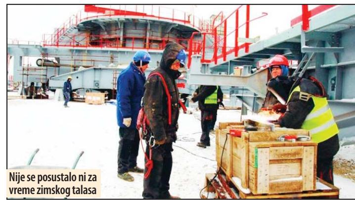
FOM“ iz Smederevske Palanke, a odnose se na izradu i montažu opreme za pogonske stanice i transportni sistemi. Od ukupno 10.165 tona, koliko iznosi težina četiri pogonske stanice i opreme za pet kilometara transportnog sistema, isporučeno je 5.900 tona opreme. Stepen montaže četiri pogonske stanice je na nivou od 90 odsto. Dosad je postavljen i 1.500 od ukupno 5.000 metara transporteru na izgrađenoj trasi.
