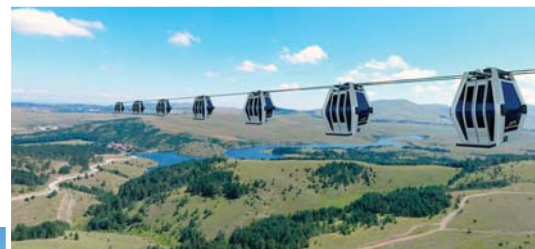
Budući izgled gondole i izgradnja gondole (dole)
