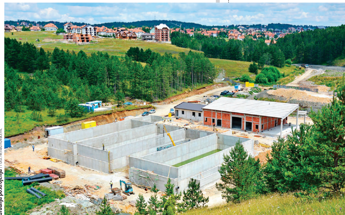
Gradnja postrojenja / Foto: Nenad Kovačević
