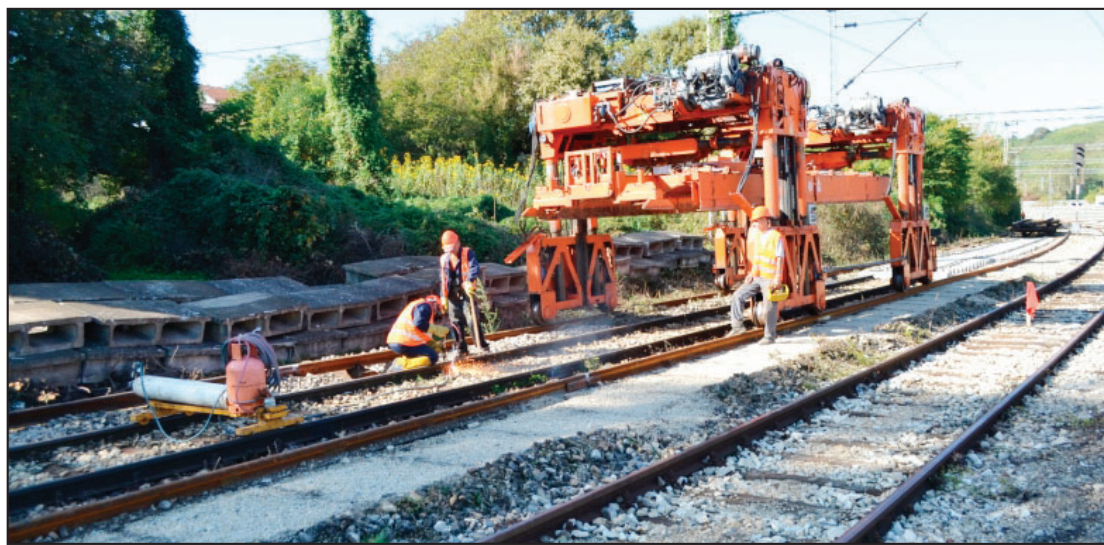
Foto: Infrastruktura železnica Srbije
